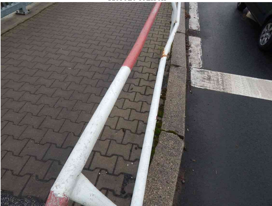
Deformované zábradlí
