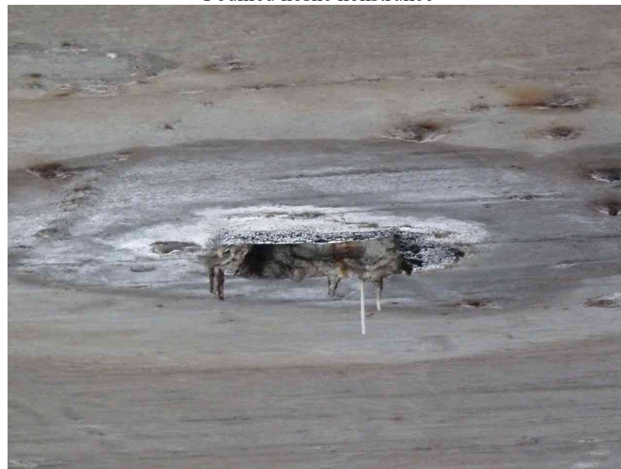
Průsaky kolem odvodňovačů
