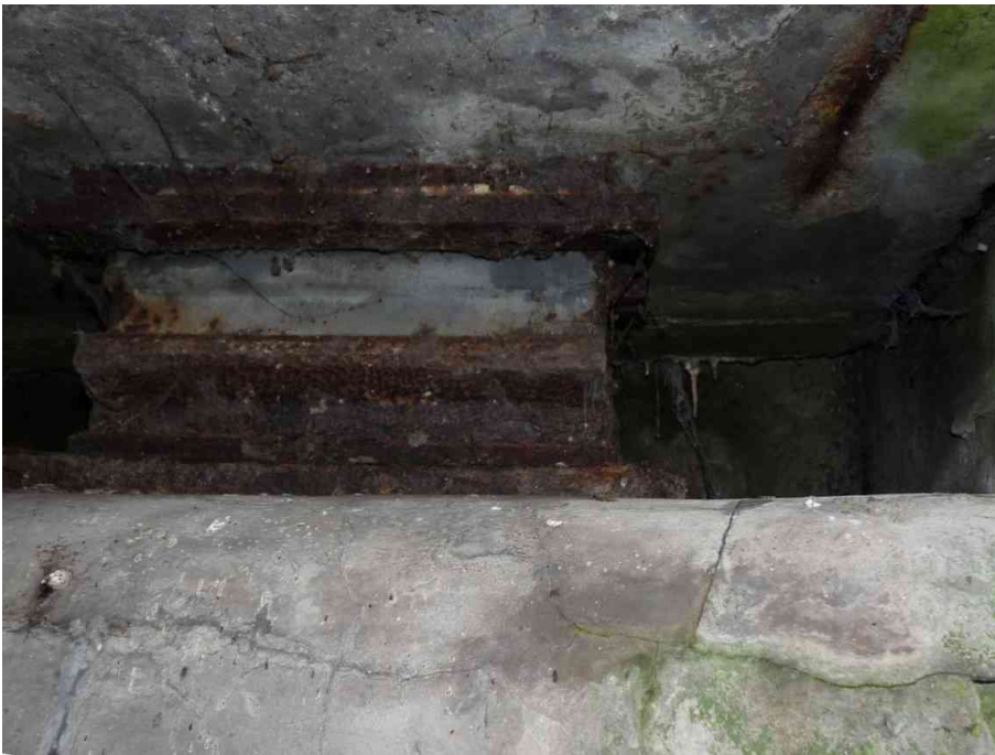
Koroze ložisek
